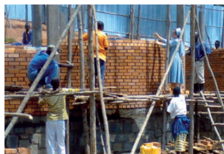
Budowa pielgrzymkowego Sanktuarium pojednania w Kibeho (Ruanda).
