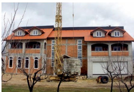
Dzięki Państwu przyszłość będzie piękna – budynek centrum diecezjalnego na Litwie w stanie surowym.
